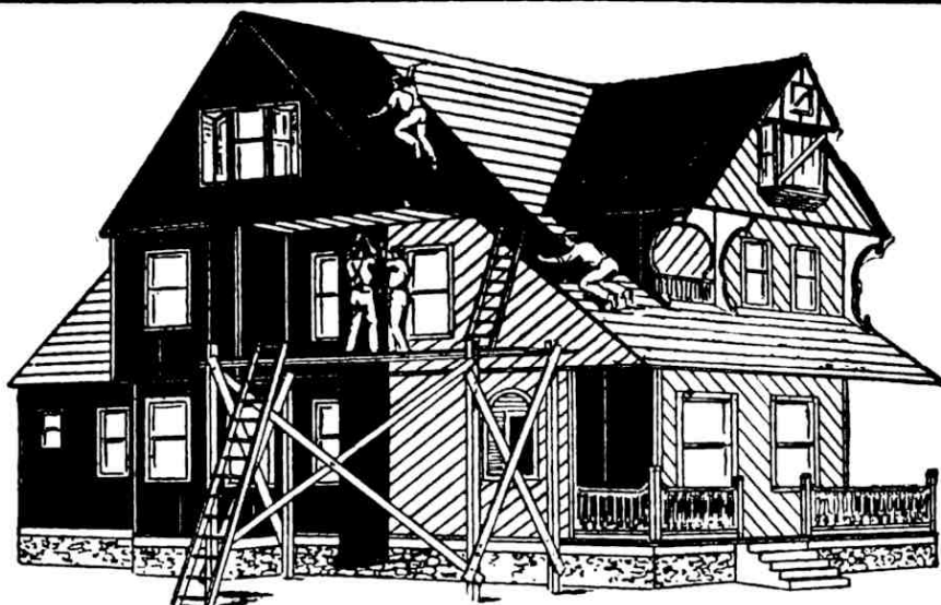
Dachdeckung mit Ruberoid, Isolierung zwischen äusserer und innerer Holzschalung der Seitenwände mit P & B Isolierpapier.
